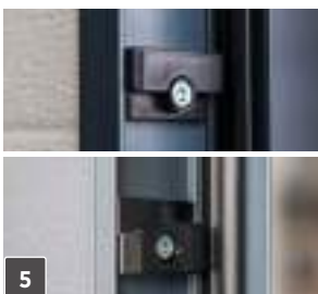
5 System zapobiegający opadnięciu skrzydła.
